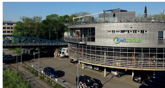
Aus dem ehemals desolaten Zweckbau ist eine beliebte Kultur- und Mobilitätszentrale mit Cafébetrieb geworden.
